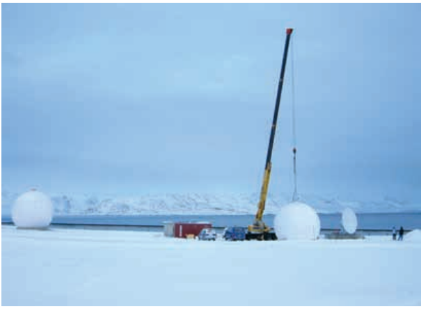
Abb. 4: Aufbau der zweiten Antenne der GFZ/DLR-Multisatelliten-Empfangsstation in Ny Ålesund im Herbst 2005 (Foto C. Falck, GFZ).
